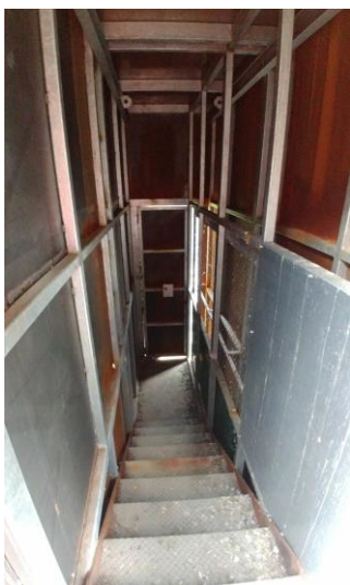
Escales d'accés a la passarel·la. Detall de la línia de vida i de la mampara corredissa.
