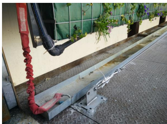
Escales d'accés a la passarel·la. Detall de la línia de vida i de la mampara corredissa.
