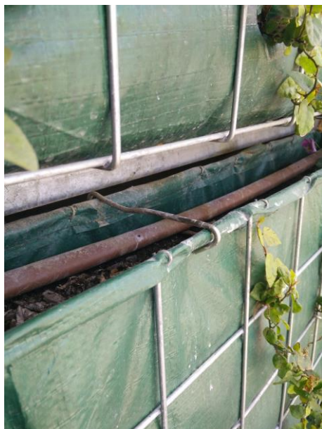
Detalls de la paret babylon. Ancoratges dels mòduls de plantació
